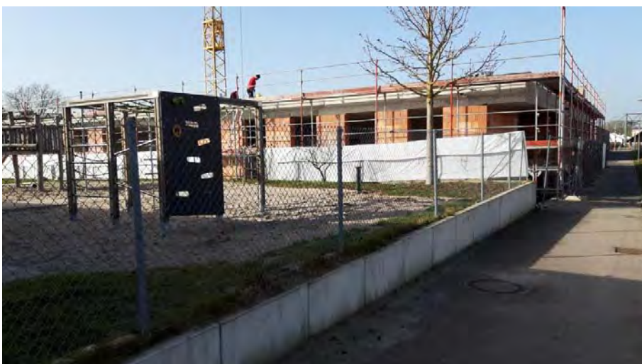
Abb. 7: Neubau auf der im Luftbild Abb. 1 noch als Wiese ausgebildeten Fläche zwischen den beiden Bestandsgebäuden
